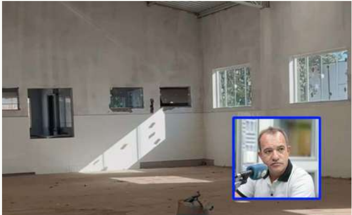
Foto: Divulgação/Escola de Nova Odessa que segue com obras paralisadas.
